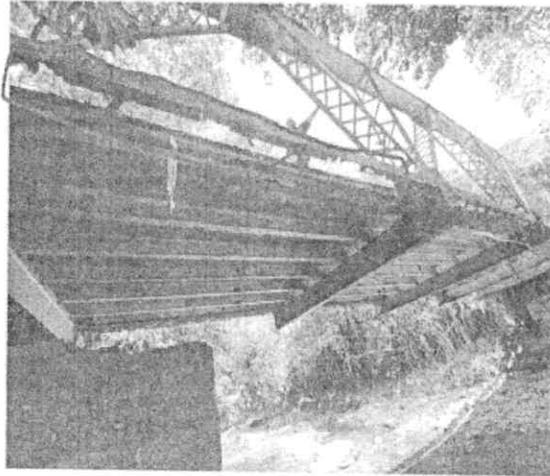
*Imagen 4. Evidencia de pérdida de sección sin diagonales de cordón inferior de viga ppa.*
