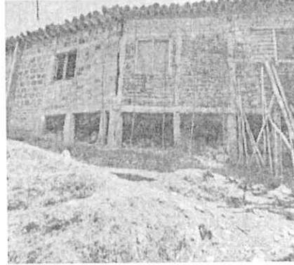
*Imagen 10 y 11. Evidencia de agrietamientos y asentamientos en zona posterior de la vivienda.*
