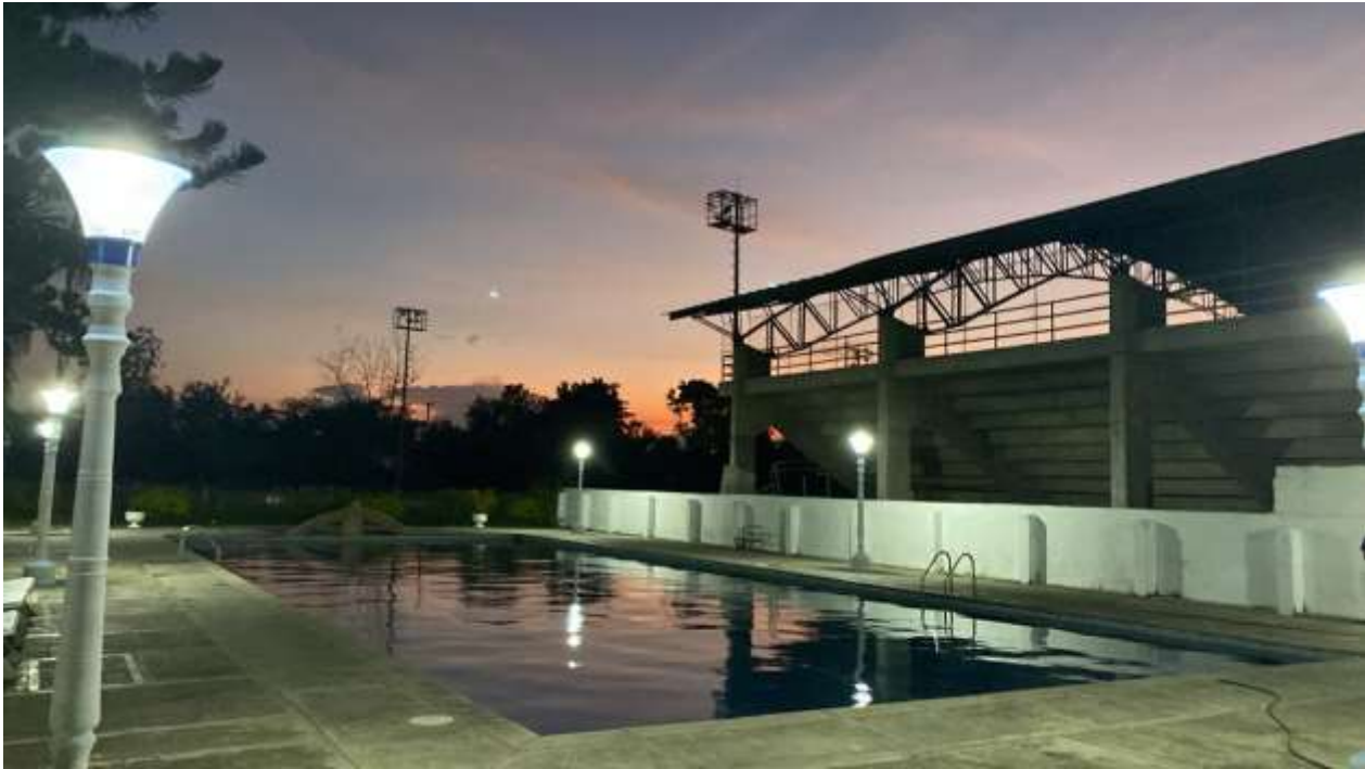
Actividad: Mantenimiento e iluminación piscina
