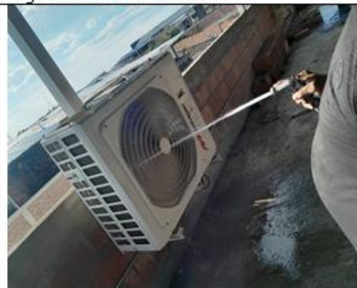
Actividad: mantenimiento aires acondicionados Lugar: sede Liceo Comercial
