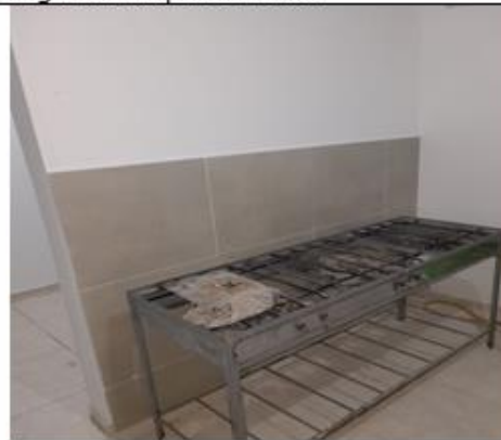
Actividad: : Adecuación cocina Lugar: sede Policarpo Salavarrieta
