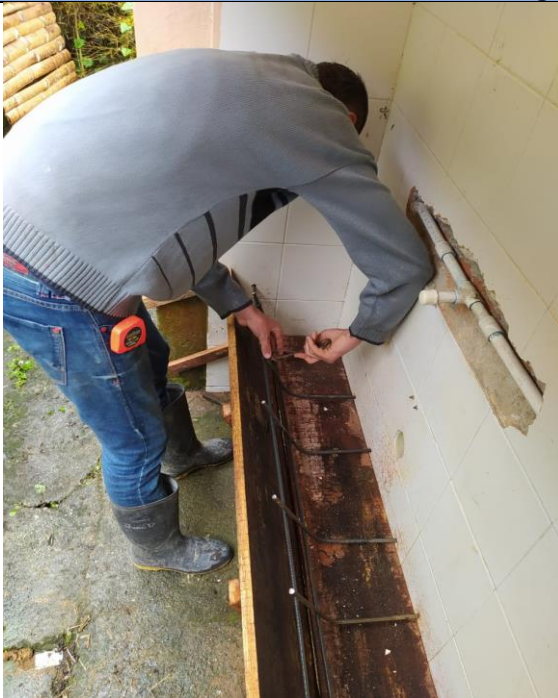
Actividad: REPARACIONES LOCATIVAS
