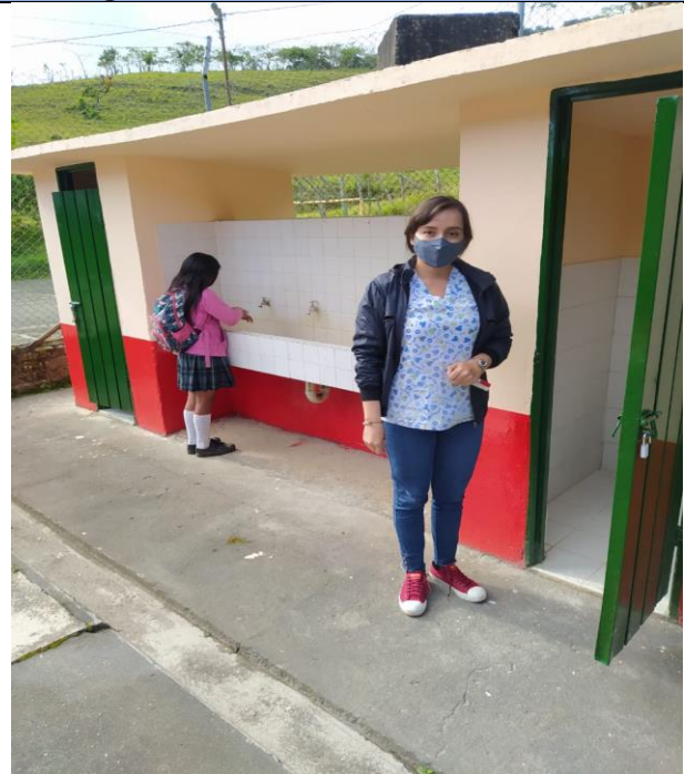
Actividad: BAÑOS RESTAURADOS
