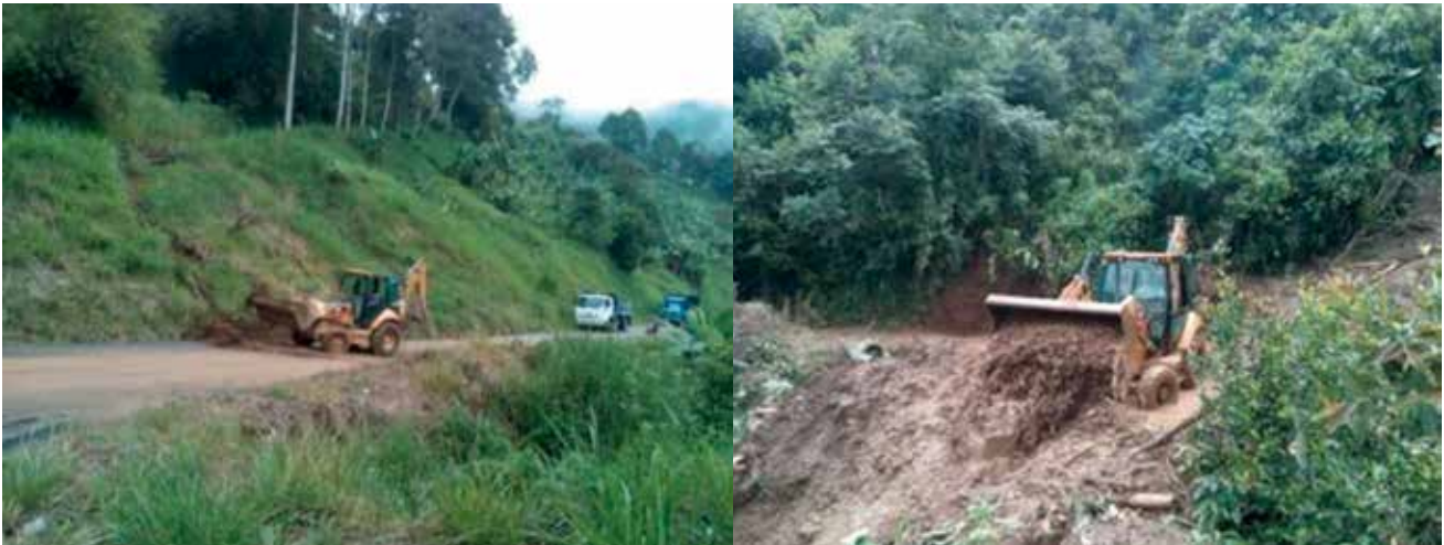
Imagen 17. Mantenimiento de vías rurales en municipio de Roldanillo
