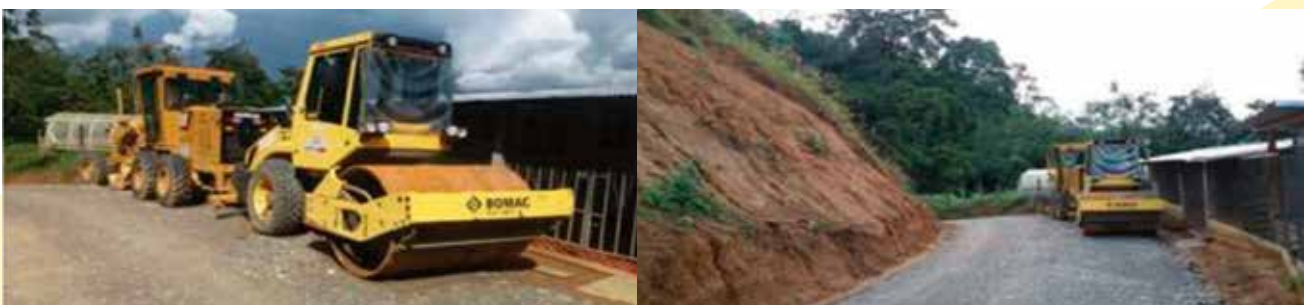
Imagen 20. Maquinaria de mantenimiento y reconstrucción
