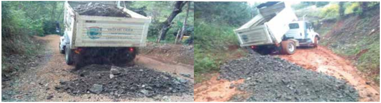
Imagen 18. Mantenimiento de vías rurales vereda San isidro, Caimital, corregimiento Carbonero y el Tambor
